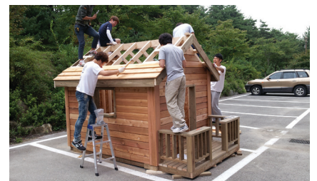
플레이하우스 지붕골조 및 마감작업
