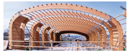
르메이 박물관 지붕의 아치로 된 곡선형태를 창출하기 위해 글루램 보들이 세워져 있다.
